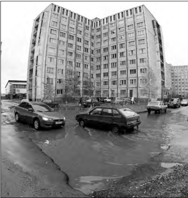
Обширная и глубокая лужа между домами №№ 26 и 30 по ул. Маяковского раскинулась не на придомовой территории, а как раз на выезде из жилой зоны.
