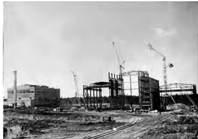
1972 год - начало монтажа главного корпуса Сургутской ГРЭС-1
