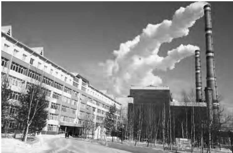
ГРЭС-1 в настоящее время
