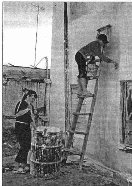
Женщины облагораживают новое здание изолятора.
