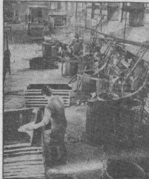
Два года существует при УПТК треста Спецнефтегазстрой цех полимеров. Теплонизоляционная плита ФРП и «скорлупа», формуемые здесь из двух компонентов синтетических смол, — эффективное средство для защиты трубопроводов строящихся ДНС и КНС.
