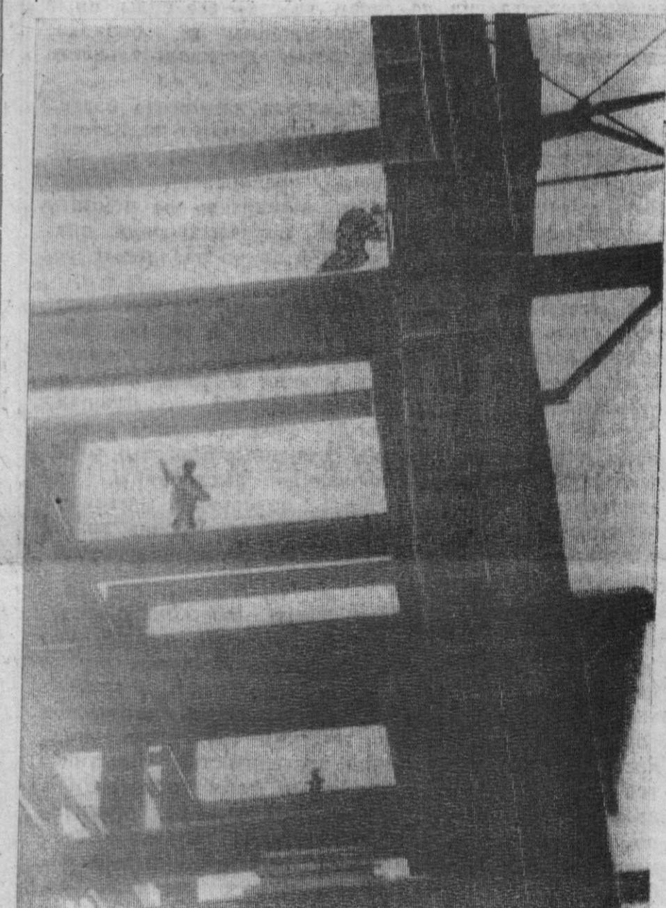
Почти в полтора раза мощнее первой будет очередная Сургутская ГРЭС: каждый ее блок будет в 800 мегаватт мощностью. К энергосистеме страны добавится еще один гигант энергетики. А пока (на снимке нашего корреспондента Е. Чупракова) идет монтаж основных узлов станции.
