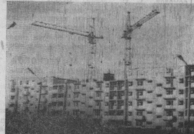
Немного прошло времени с тех пор, как начал был монтаж этого жилого дома. В нем будет 144 квартиры. Здание подобной серии строится в Сургуте впервые — из деталей Братского ДСК. Сооружение дома близится к завершению.
