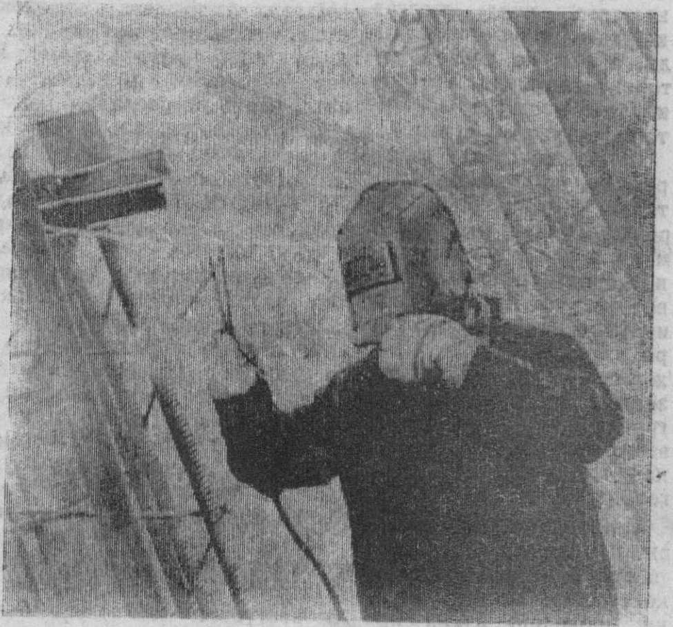
НА СНИМКАХ: растет участок СУ ГРЭС-2 главный корпус ГРЭС-2: Г. Г. Гринин, ударник сварки, подковник, плотник-бетонщик перво-коммунистического труда.
