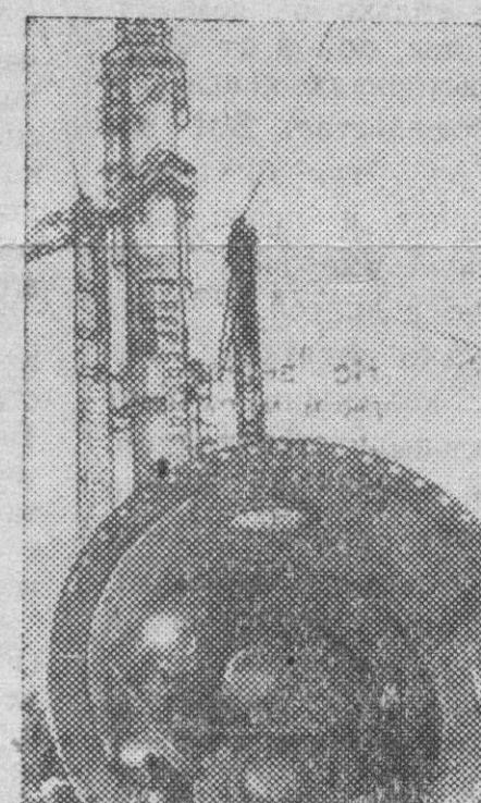
Продолжается сооружение Тобольского нефтехимического комбината, пуск которого предусмотрен в текущей пятилетке. Сейчас ведется монтаж очередной ректификационной колонны газофракционирующей установки (на снимке вверху). Она предназначена для переработки попутного нефтяного газа, поступающего с северных промыслов Тюменской области.
