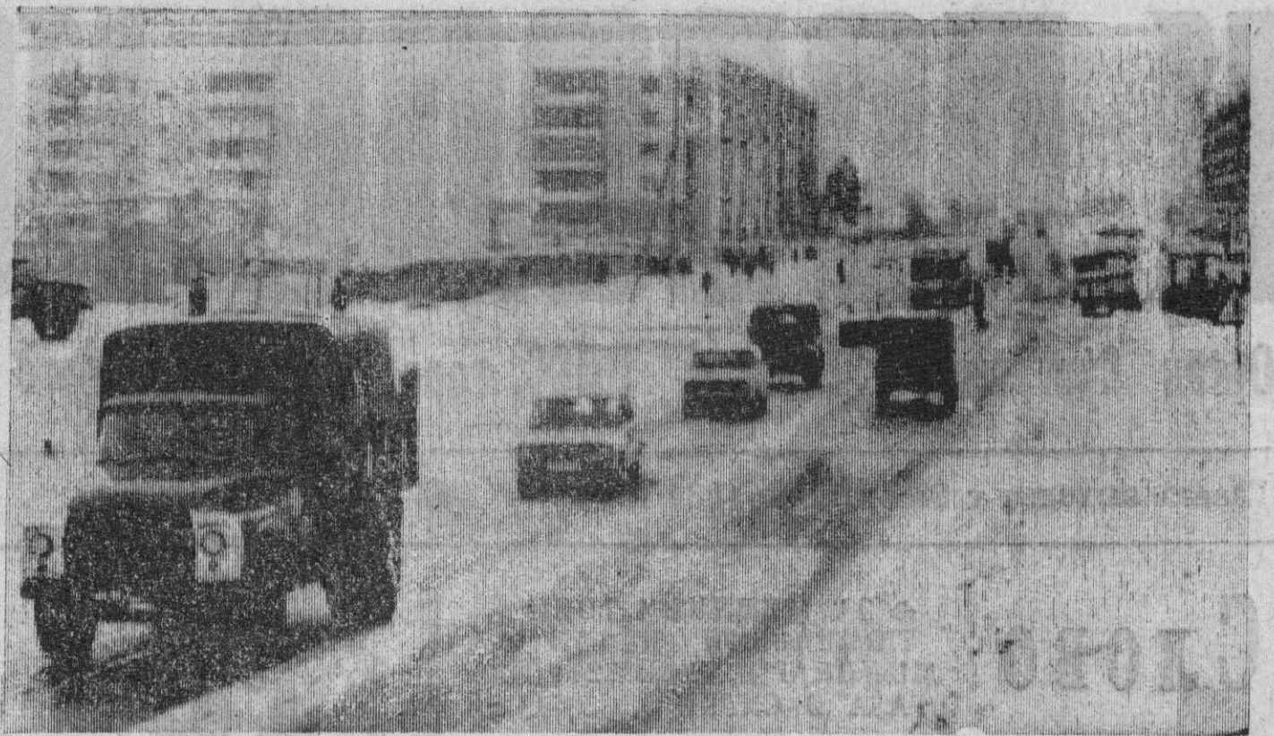
Растет ввысь и вширь наш город. Этот снимок наш фотокорреспондент Е. Чупраков сделал на улице Энергетиков, где в последние годы ведется интенсивное строительство жилых домов и объектов соцкультбыта.
