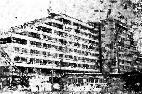
МОСКВА. На Варшавском шоссе близ Московской кольцевой автомобильной дороги строятся СУ № 93 строительно-монтажного объединения № 1 Главмоспромстройа возводят мотель-кемпинг.
