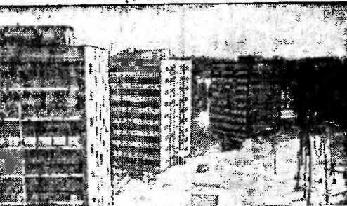
ЗДЕСЬ ЖИВУТ СТРОИТЕЛИ УСТЬ-ИЛИМСКОЙ ГРС. (ТАСС).
