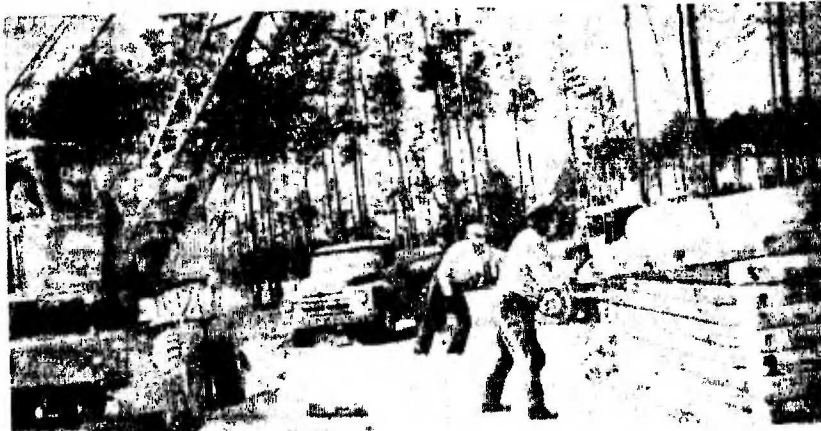
ЗДЕСЬ БУДЕТ ДОРОГА.
