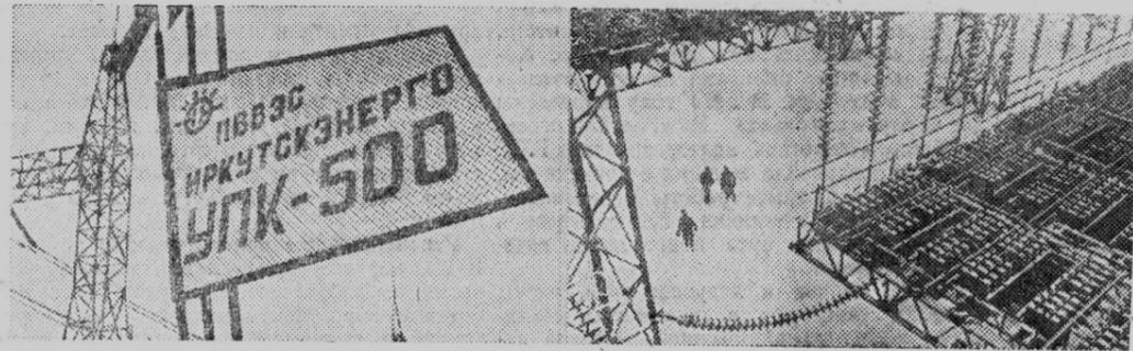
Энергию Братской ГЭС несут потребителям Восточной Сибири высоковольтные линии электропередачи. Две из них — ЛЭП-500, связывающие Братск с крупным промышленным центром края Иркутском, протянулись более чем на полтысячи километров. Чтобы снизить потери напряжения на этом огромном пути и увеличить передаваемую по линии мощность, в Иркутской области действует установка продольной компенсации (на снимке).
