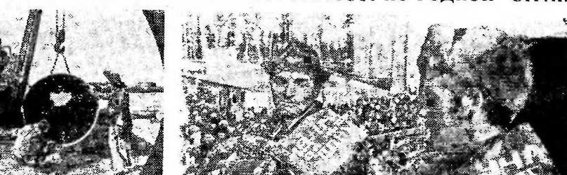
большого диаметра (1420 мм) фирмы «Маннесманн [ФРГ]» и трубоукладчики американской фирмы «Катерпиллер».
