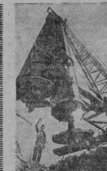
Саратовская область. На строительстве Балаковского завода фосфорных удобрений в качестве фундаментов зданий будут использованы буро-набивные сваи. Этот прогрессивный метод, заимствованный у строителей Камского автомобильного завода, сократит в несколько раз объем земляных работ.
