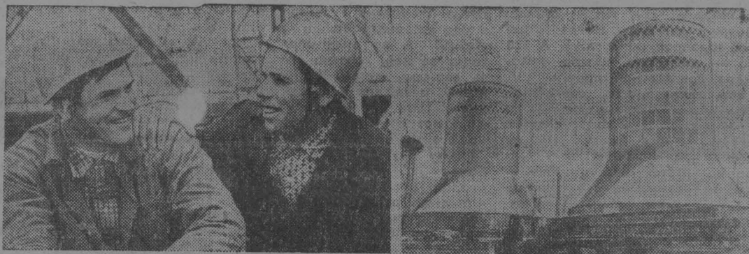
Армянская ССР. В городе химиков и энергетиков Раздане ведется строительство крупнейшей в Закавказье ГРЭС. На снимках: общий вид градирен Разданской ГРЭС; бригады монтажников-высотников В. Ушаков и Э. Мусаэлян. Коллективы, которыми они руководят, выполняют ежедневно сменные задания на 130-145 процентов.
