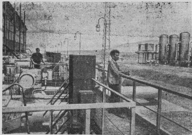
Азербайджанская ССР, Кази-Магомед. На трассе трансиранского газопровода вступила в строй новая компрессорная станция. Здесь смонтированы восемь центробежных нагнетателей с электроприводом. Такие машины на электрическом «ходу» используются в Закавказье впервые.
