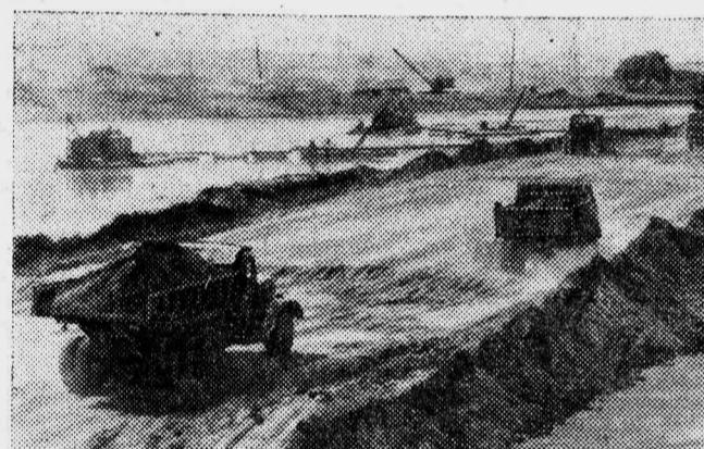
**Узбекская ССР.** На реке Амударье началось строительство Тюмюнского гидроузла. Десятки мощных землеройных машин работают в котловане. Полным ходом идет выемка грунта под здание ГЭС.
