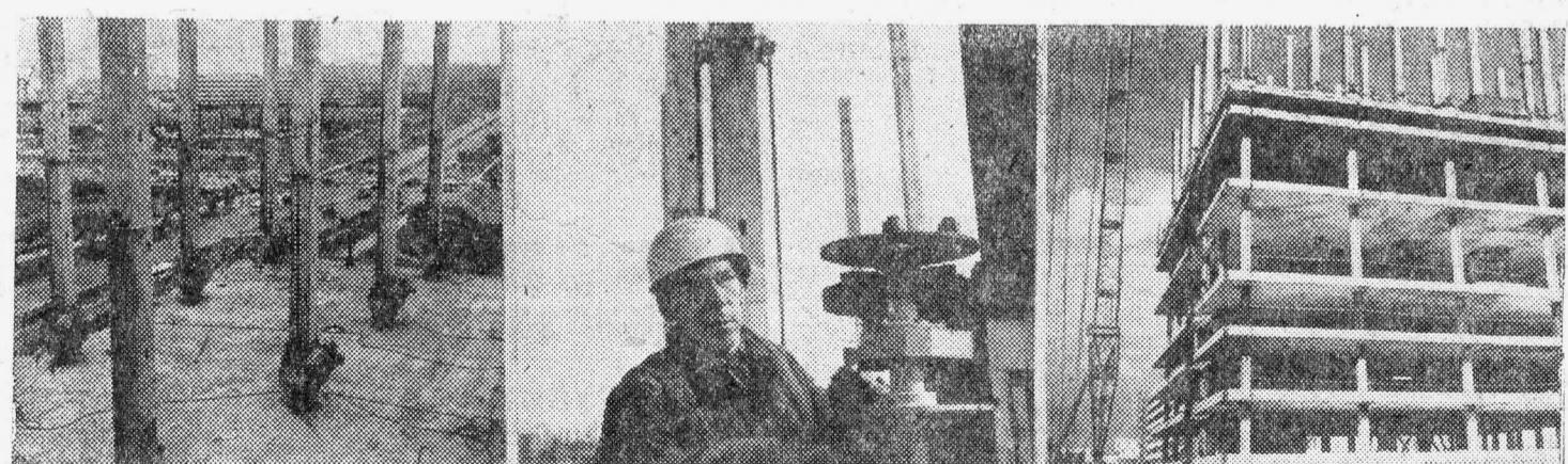
Москва. На строительной площадке в 28-м квартале Новых Черемушек, где сооружается 15-этажное здание Центрального государственного архива города Москвы, почти не видно людей. 550-тонные плиты междуэтажных перекрытий поднимаются на заданную высоту мощными электрическими домкратами, укрепленными на стальных колоннах. Контроль за работой домкратов производится оператором с пульта управления подъемом.
