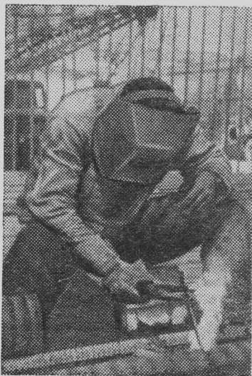
На строительстве гидротехнического комплекса на реке Евфрат трудится более семи с
