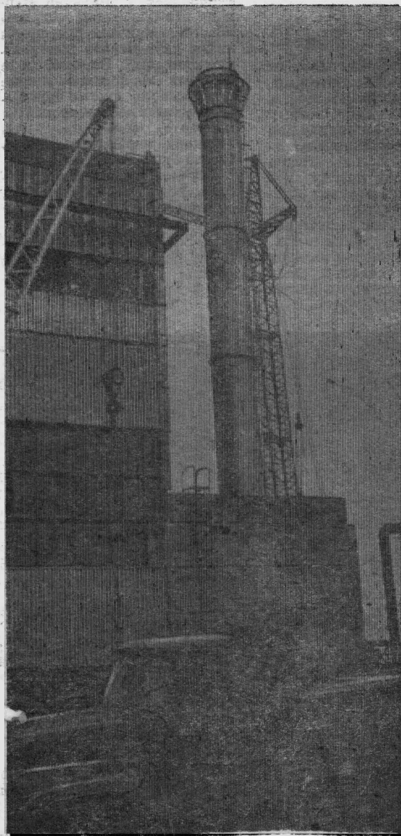
Высоко в небо вознеслась многометровая труба пуско-резервной ТЭЦ как символ героического труда ее строителей. Скоро пуск ТЭЦ, на стройке кипит напряженная работа.
