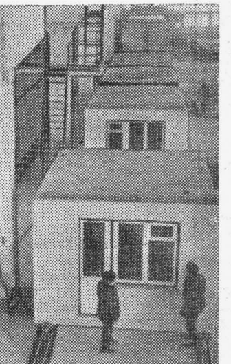
Белорусская ССР. 100 тысяч квадратных метров жилой площади в год, или около 30 пятиэтажных 90-квартирных домов, будет выпускать ежегодно Минский завод объемно-блочного домостроения. Он вступил в эксплуатацию в конце прошлого года.
