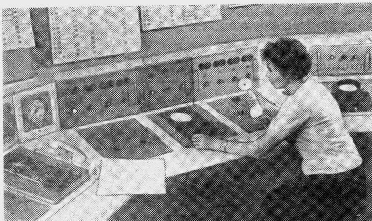
Сахалинская область. Нефтепромысел Восточное Эхаби механизирован. Контроль за каждой скважиной осуществляется с диспетчерского пульта.
