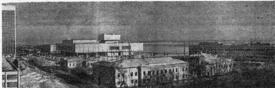
Ульяновск. Близится к завершению строительство Ленинской мемориальной зоны. Ударно трудится коллектив строителей, возводящий объекты величественного памятника вождю пролетариата.
