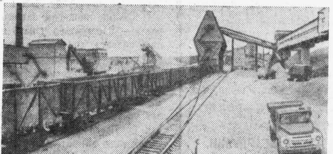
Гниванский гранит известен как хороший строительный материал. На его добыче в карьерах работают мощные экскаваторы, автосамосвалы, буровые станки. Все процессы производства механизированы. В Гниванском карьере, что в Винницкой области, сооружен мощный камнедробильно-сортировочный завод. Его годовая производительность 1 миллион 700 тысяч кубометров переработанной горной массы.
