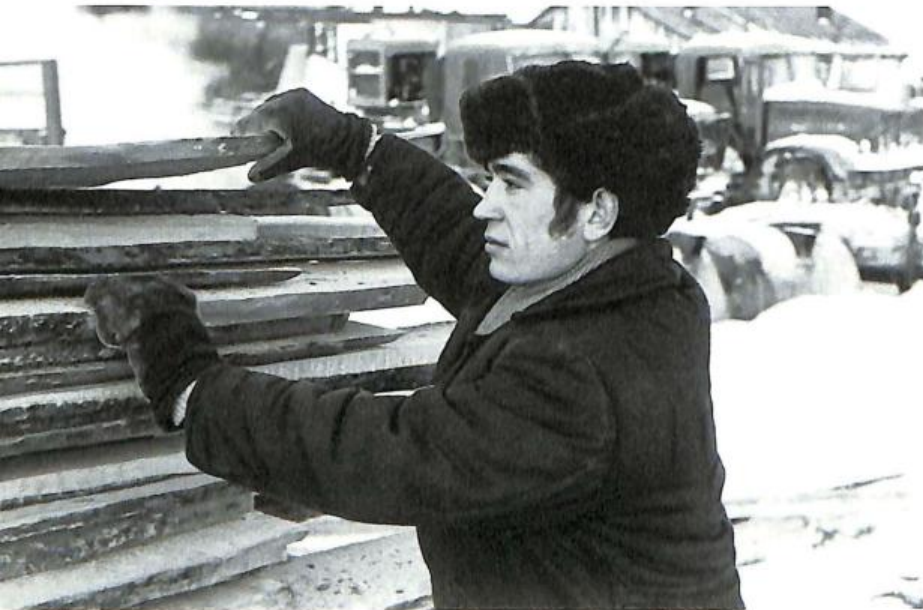
И.Л. Смертюк, начальник стройцеха. З.Г. Загидуллин, плотник. Электромонтеры М.Х.Габидуллин, Е.С.Ситников.
