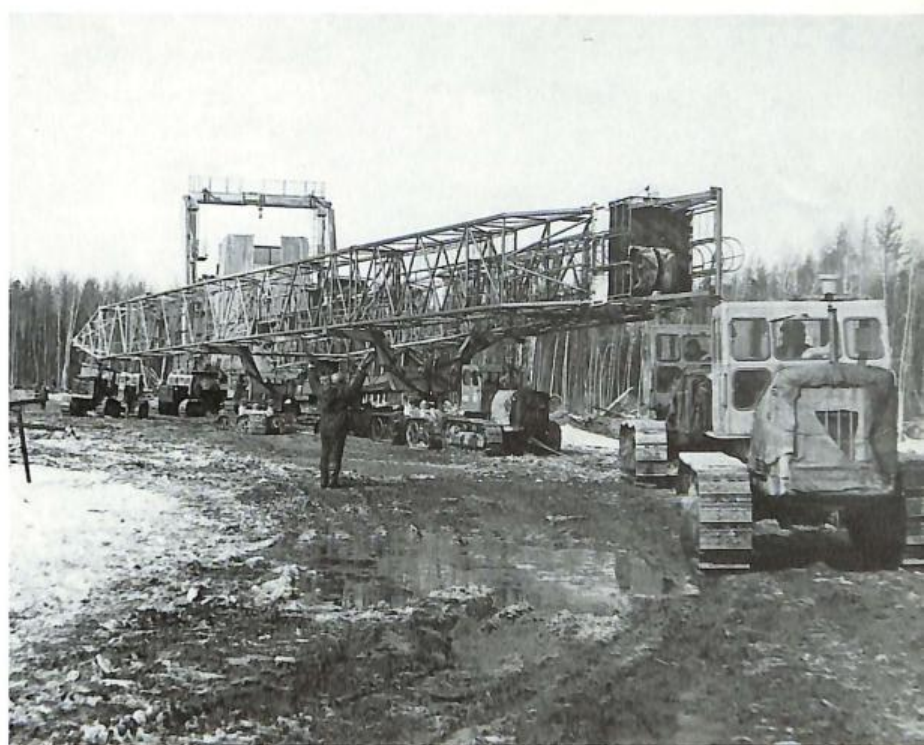
Знатные бригады вышкомонтажников Н.И. Литовченко и А.Г. Тимченко.
