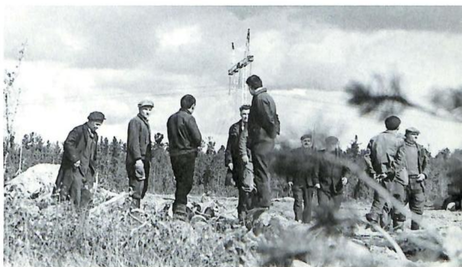
Здесь будет пробурена еще одна скважина...
