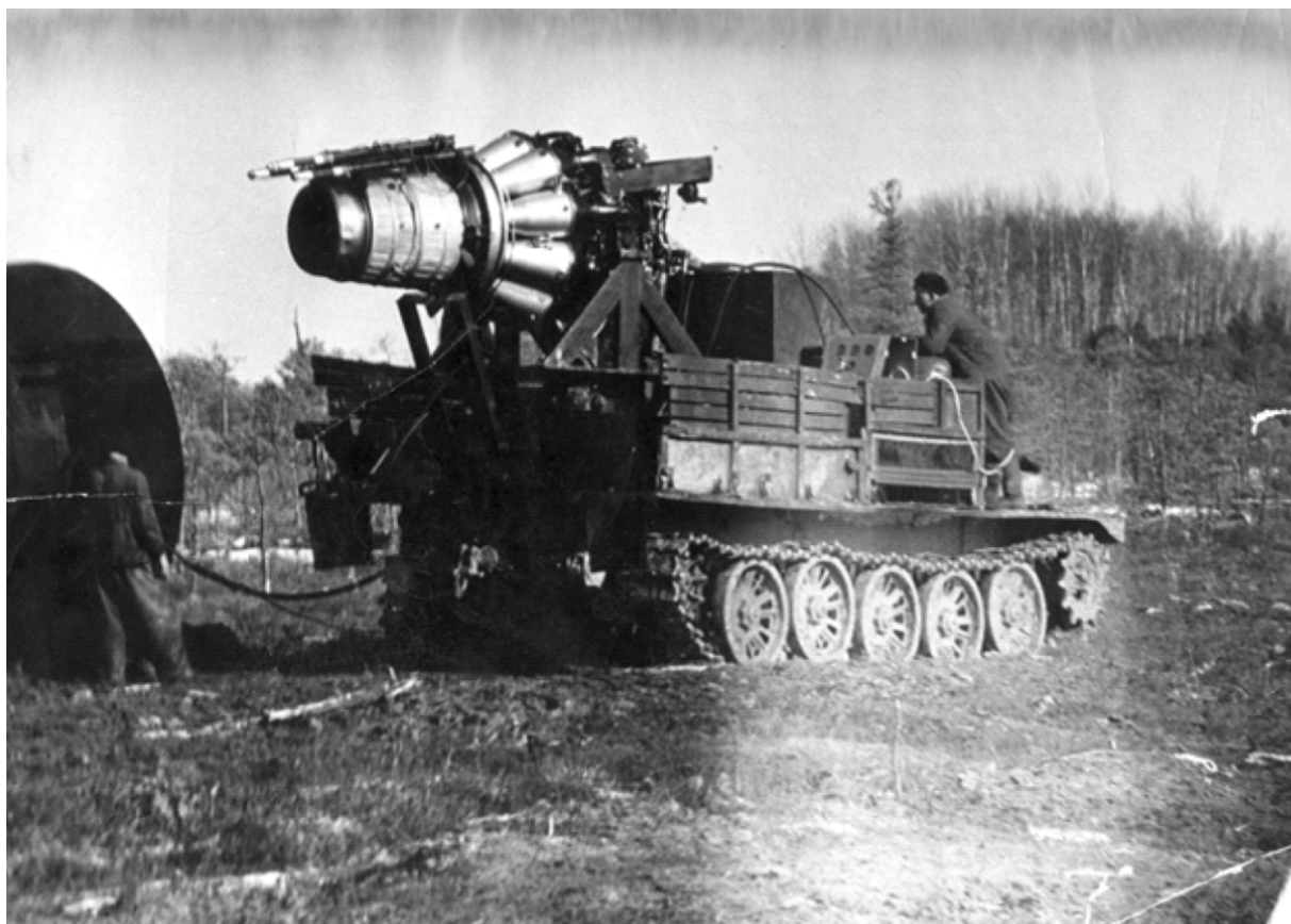
Реактивная пушка для укрощения нефтяного фонтана на скважине Р-6 Варьеганской площади
