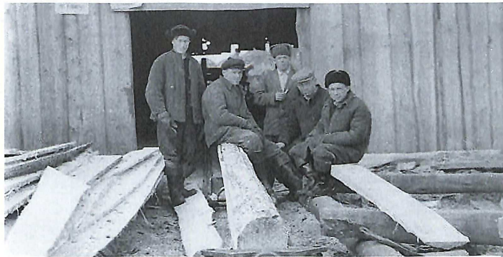
Бригада пиломатериалов лесотарного цеха после выполнения предмайских обязательств
