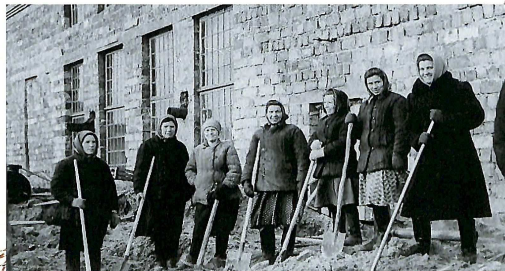
Бригада у стены дизельной электростанции. 1961 г.
