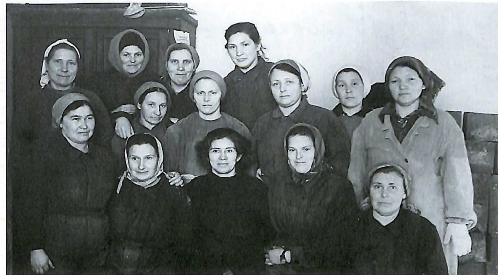
Бригада по изготовлению блоков для строительства цехов предприятия. 1962 г.
