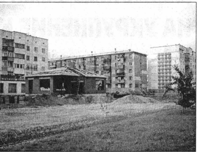
Проезжую часть и пешеходные тротуары строители обещают сдать в этом году.
