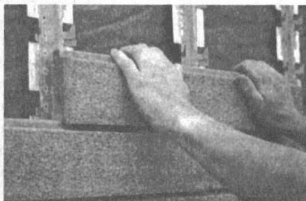
Монтаж панелей «Матмос»
