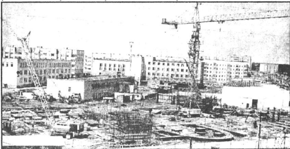
Началось строительство бизнес-центра АО НК «Сургутнефтегаз».
