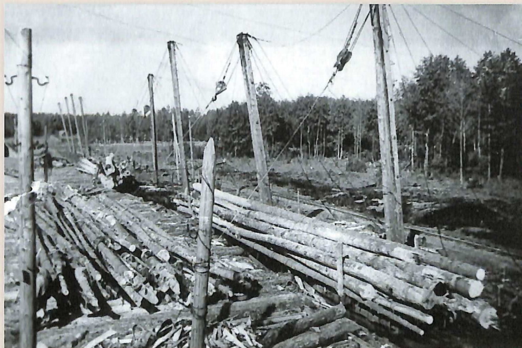
Лесопогрузочное приспособление в период отсутствия механизации. Начало 1970-х гг.
