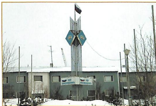
Первые административно-бытовые здания НГДУ «Комсомольскнефть»
