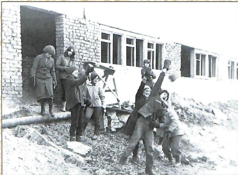
Строительство базы СУТТ-1. Начало 80-х.
